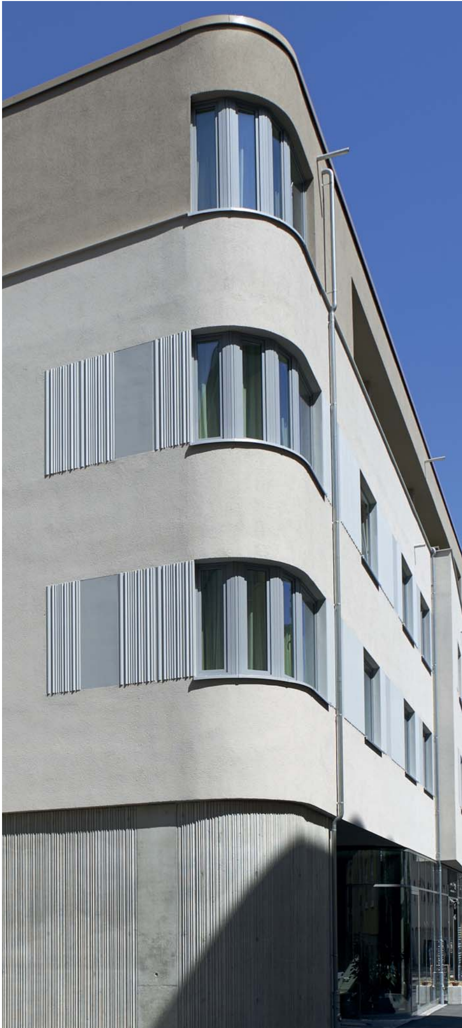
Novostavba hotelu „Zur Noll“, Jena, DE Architekti: Sabine Walther, Jena, DE Realizace: Neubauer Maler a Fußboden GmbH, Bad Berka, DE Řešení od Sto: Zateplovací systém StoTherm Classic®, fasádní prvky StoDeco, předsazený, odvětrávaný fasádní systém s omítkou StoVentec R Foto: Christian Günther, Lipsko
