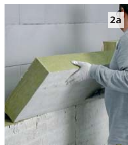
Sto-Speedlamelle Tepelně izolační lamela z minerální vlny podle EN 13162; vysoká pevnost ve smyku díky kolmým vláknům
