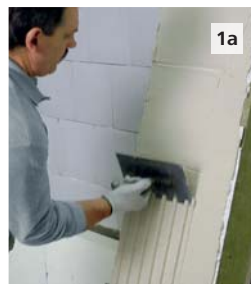
Sto-Steinwolleplatte Tepelně izolační deska z minerální vlny podle EN 13162
