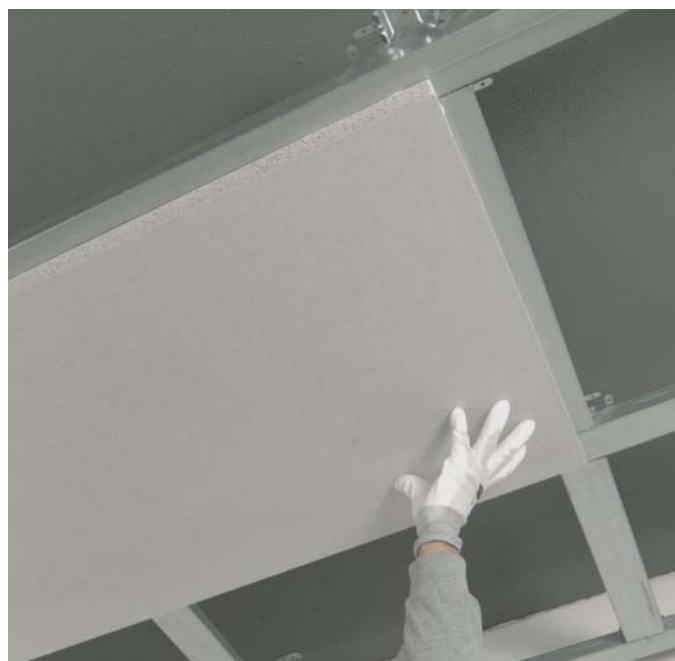
Přimáčknutí akustické desky
